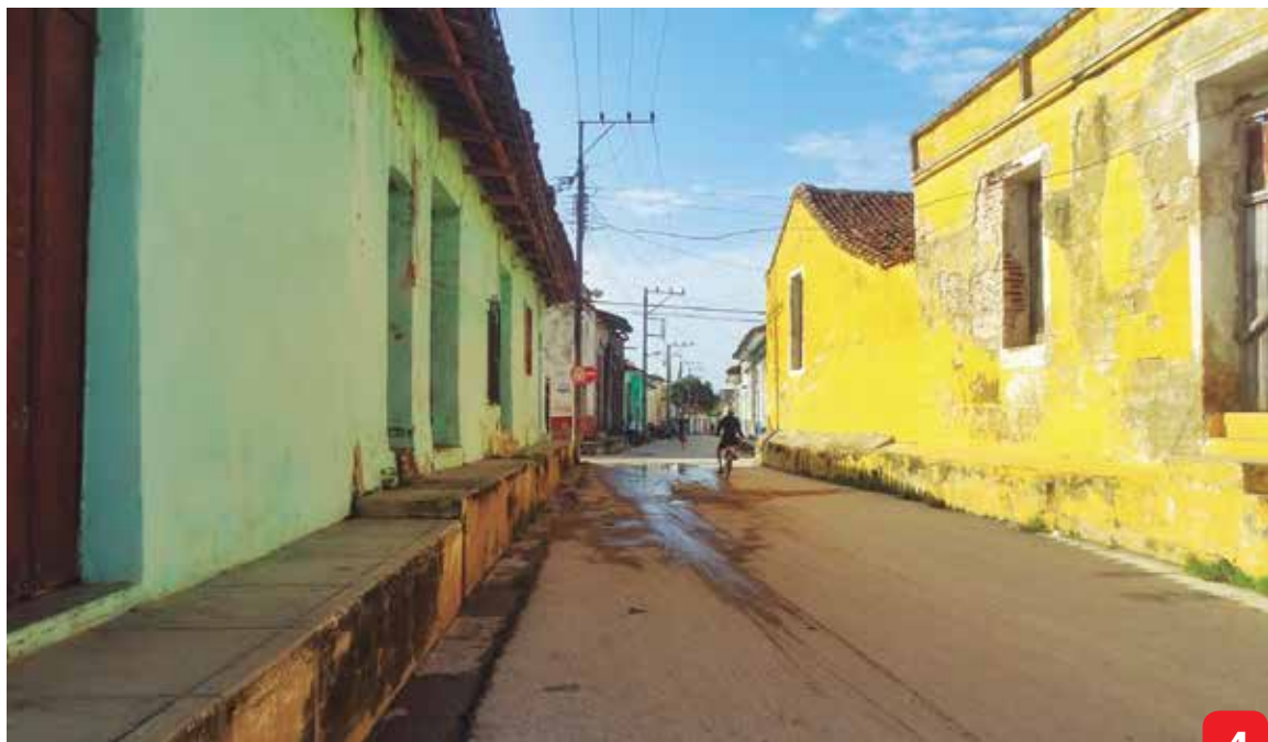
Por no pocas calles corren, en cambio, otras aguas residuales.
