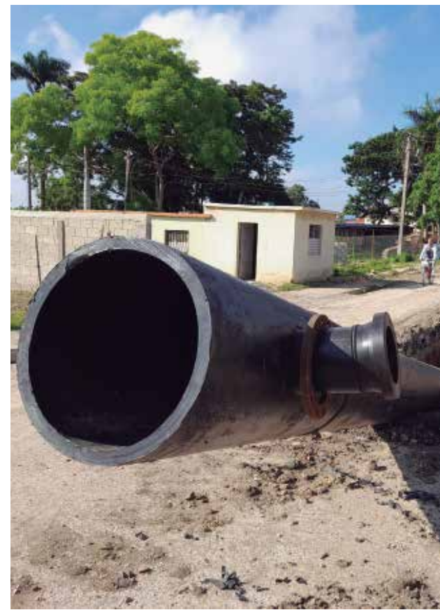
Actualmente se trabaja en el cruce de la Carretera Central.
