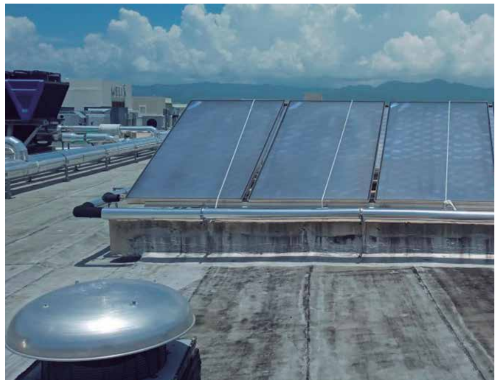
En las azoteas del hotel prosigue el montaje de las celdas fotovoltaicas para aumentar la generación de energía solar.
