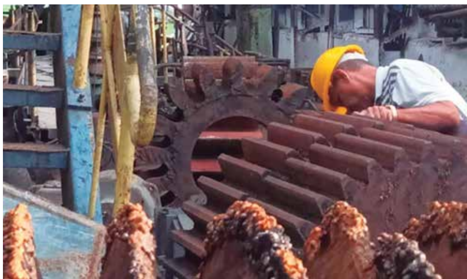
Las reparaciones del central son el centro de atención. /Foto: Facebook
