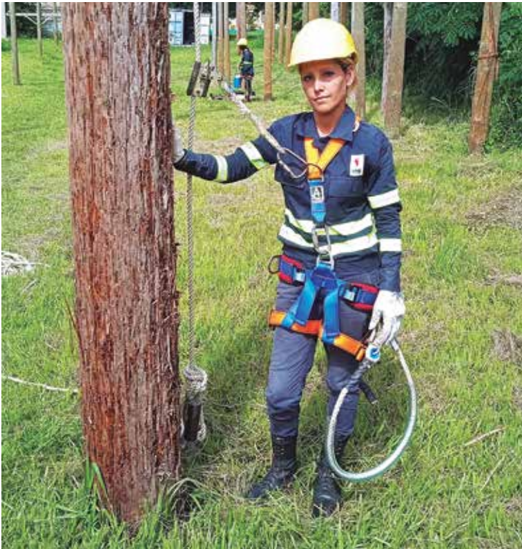
Este es un trabajo muy importante, asegura. /Fotos: Cortesía de la Empresa Eléctrica
