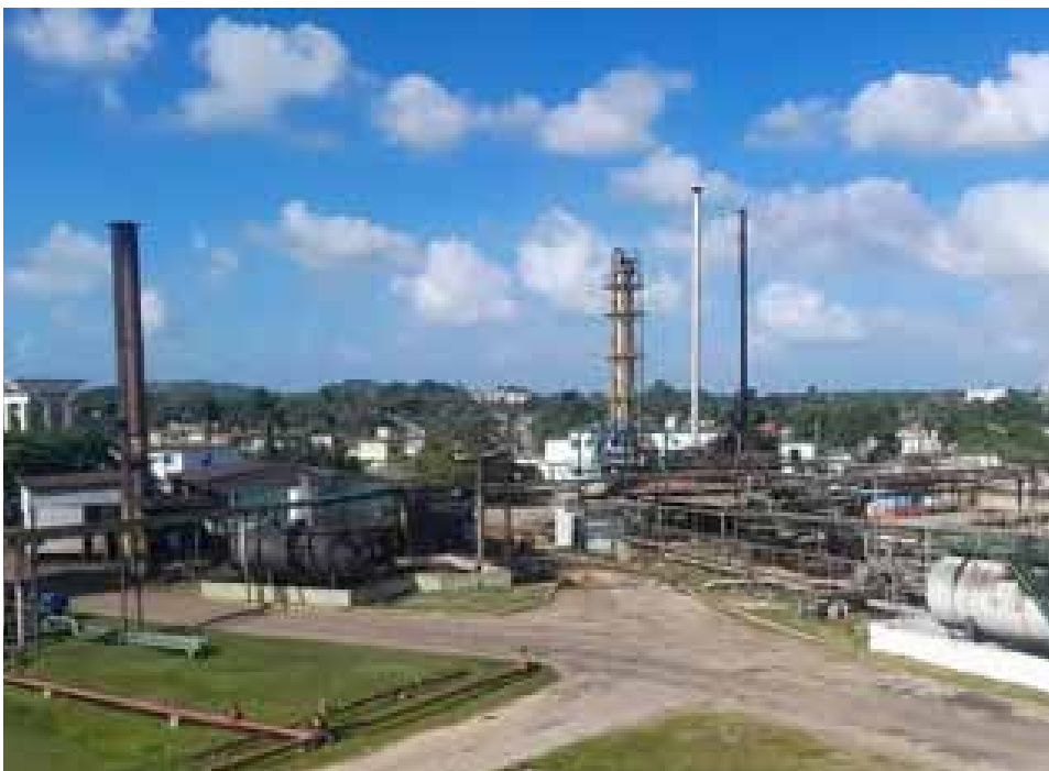
La planta mantiene estabilidad en los surtidos, pese a las limitaciones. /Fotos: Cortesía de la empresa
