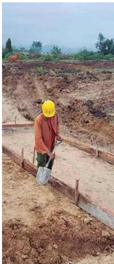
El nuevo parque solar se basa en el sistema de piralotes fundidos.
